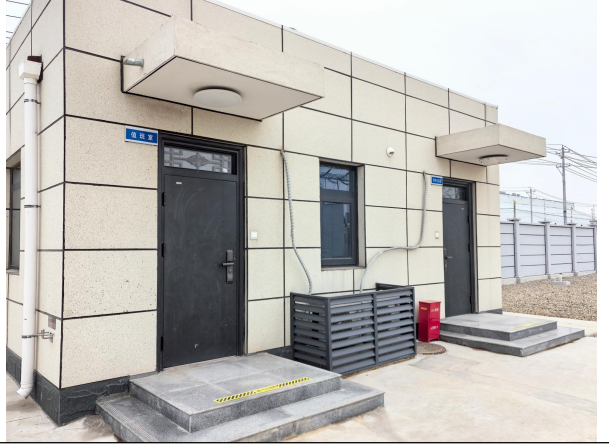
值班室及消防控制室
