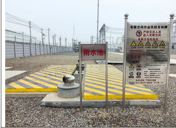
厂区雨水收集池
