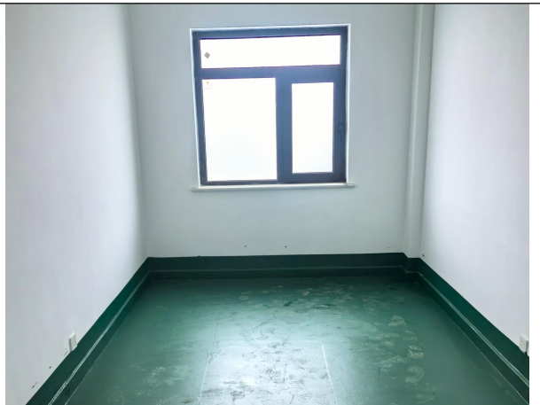
危废贮存库内部
