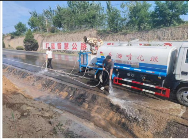
施工道路冲洗
