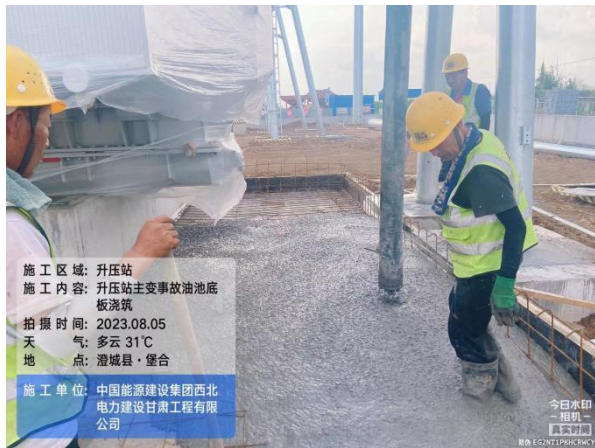
升压站事故油池浇筑
