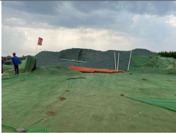
风电场开挖土方覆盖
