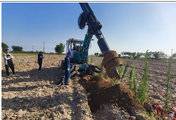
集电线路塔杆基坑开挖
