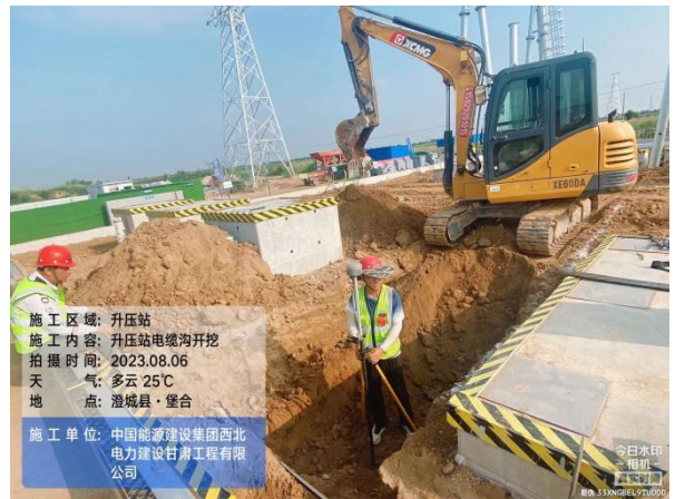
升压站电缆沟开挖
