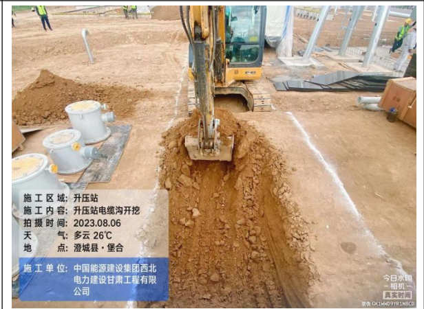
严格控制施工作业带
