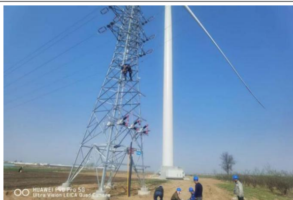
架空线路施工
