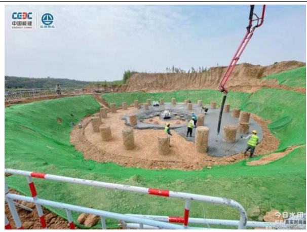
风机施工区域土方覆盖
