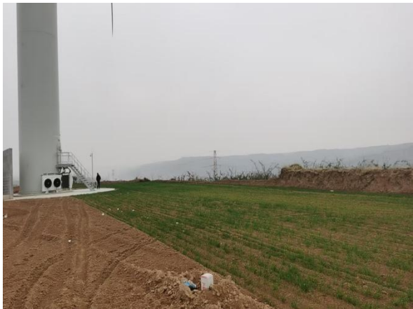
施工临时占地复耕
