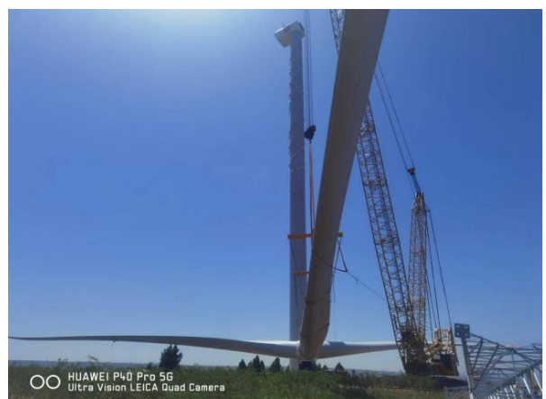
风机叶片吊装
