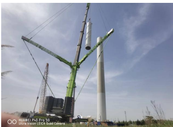
风机塔筒吊装
