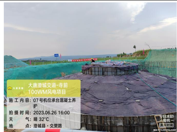
风机施工场地周边地表覆盖
