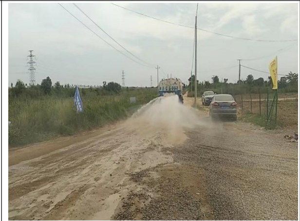
施工道路洒水抑尘
