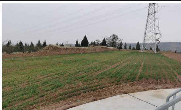
施工占地复耕
