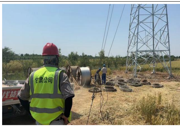
集电线路施工牵张场
