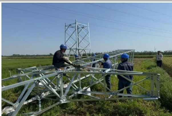
集电线路塔杆组立
