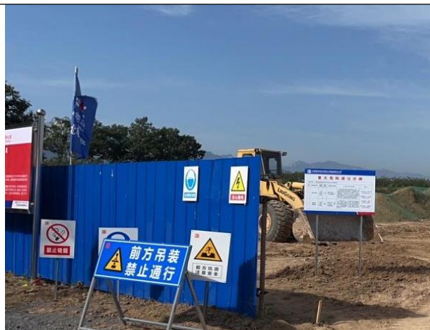
施工区硬质围挡
