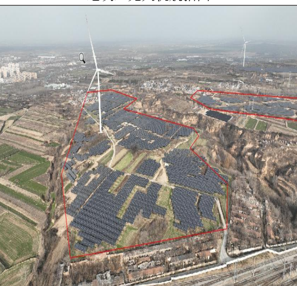
地块四无人机航拍图
