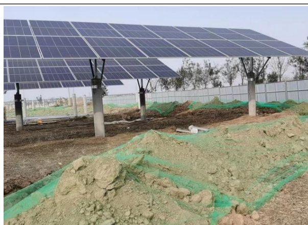
地缆沟开挖土方苫盖
