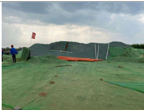
施工区基础开挖土方苫盖
