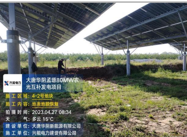
光伏电站土地复耕
