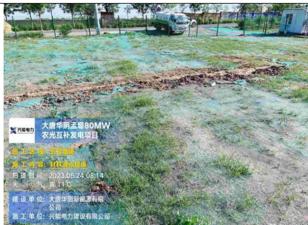
未施工区域地表苫盖
